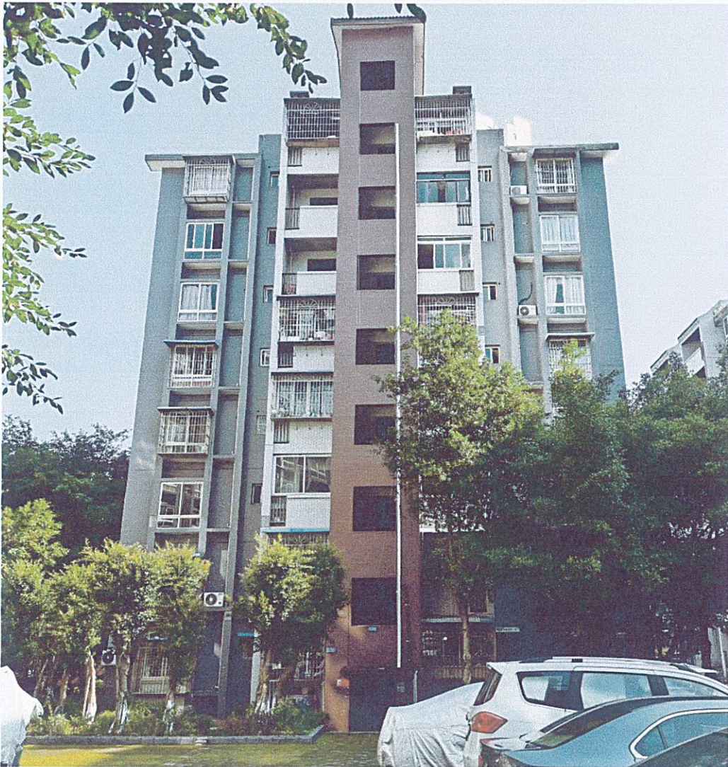
图片 1: 长寿区桃西雅图 12 幢 1 单元外观现状 (楼梯侧)
